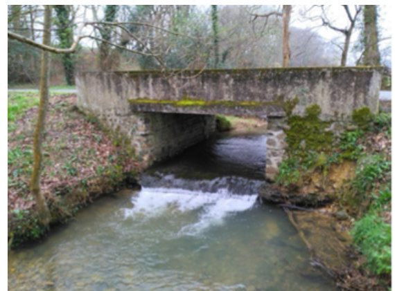
Vue de la face aval du pont
